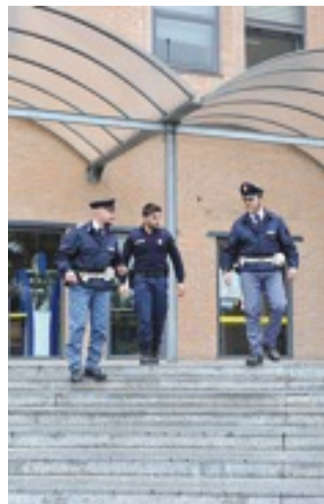
PAURA Le Poste di via Fascetti
